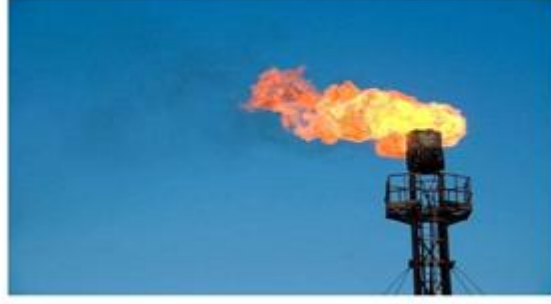
شكل 1.1. المشعل المستخدم لحرق الغازات؛ (مجلة التقدم العلمي – https://taqadom.aspdkw.com/www )
